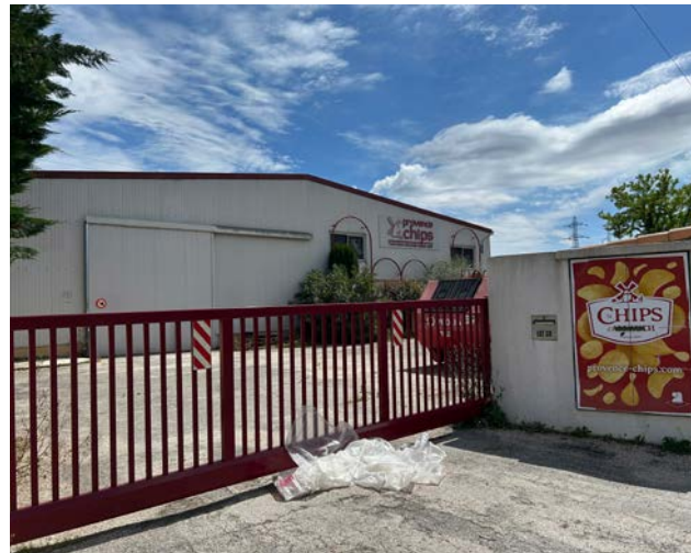
Les grilles de l'usine Provence Chips sont fermées. La société est en liquidation judiciaire depuis le 19 mars. / PHOTO M.LL.
