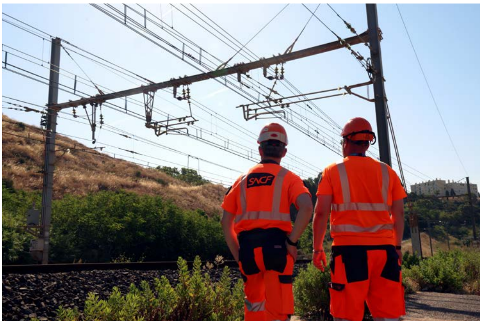
Des agents de SNCF Réseau hier lors de l'inspection de caténaires dans le quartier de Saint-Louis, à Marseille (16°). / PHOTO NICOLAS VALLAURI
